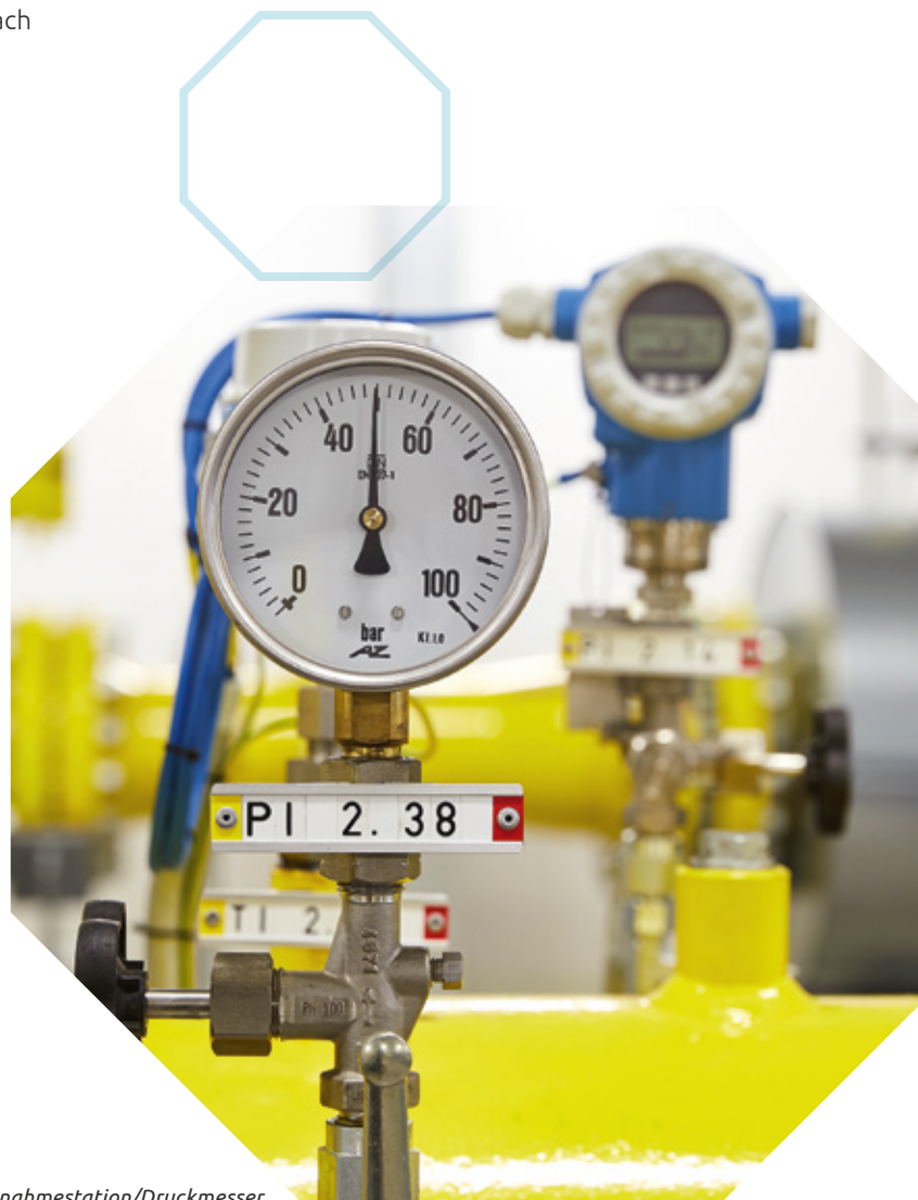
Übernahmestation/Druckmesser
